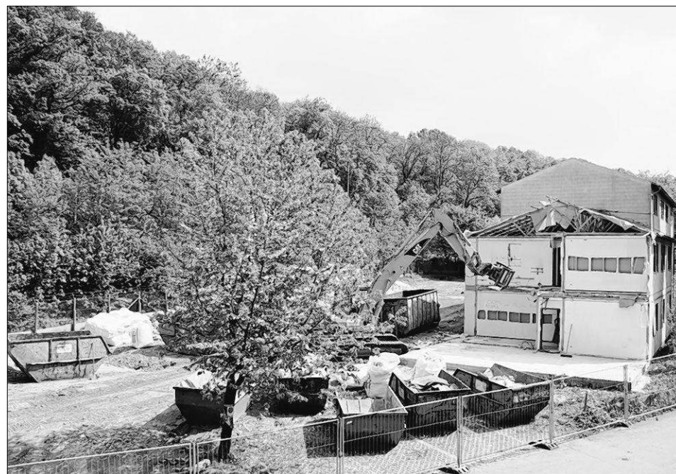
Die komplette linke Reihe der Containerbauten fiel bereits dem Abrissbagger zum Opfer. Bald wird vom ehemaligen Flüchtlingsdorf nichts mehr zu sehen sein.
